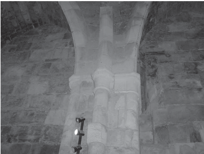
Fig. 42: Limassol Castle, réduit , wall respond, detail of vault springing [M. Olympios].
